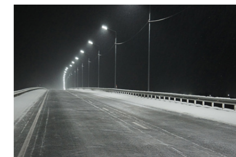
Фед. трасса Р-255 «СИБИРЬ» Тулунский район, Иркутская область Светильники BEST STREET-04 160
